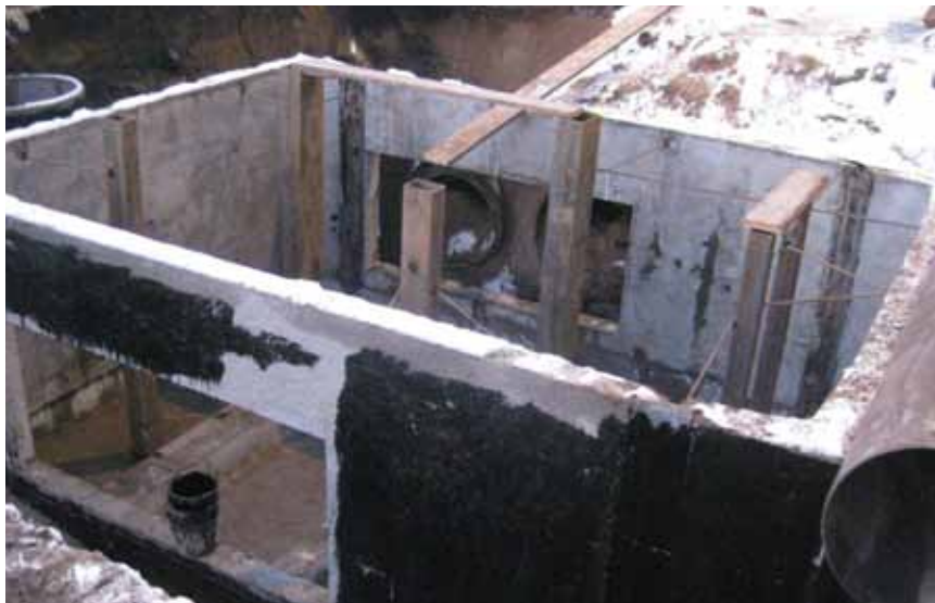
Строительство тепловой камеры
