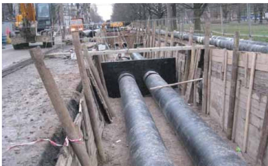
Монтаж неподвижной опоры
