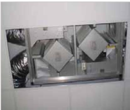
Рис. 6. Централизованный агрегат типа HRV фирмы REMAK с двухкаскадным пластинчатым рекуператором теплоты
