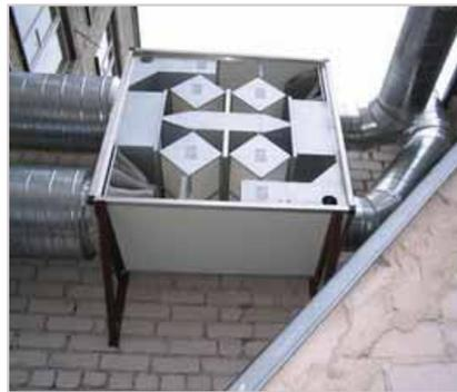
Рис. 7. Централизованный агрегат типа HRV фирмы REMAK с четырехкаскадным пластинчатым рекуператором теплоты
