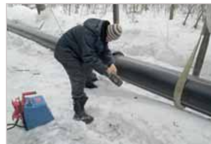
Рис. 2. Тот же объект, что и на рис. 1. Недопустимые забоины на трубе и муфте с ЗН Ø 400 мм в результате применения стальной кувалды для посадки муфты
