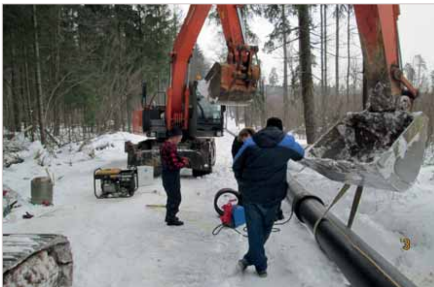
Рис. 1. Выход расплава на муфте с ЗН из-за наличия изгибающих усилий и провиса трубы при сварке трубы Ø 400 мм. Позиционер не применялся
