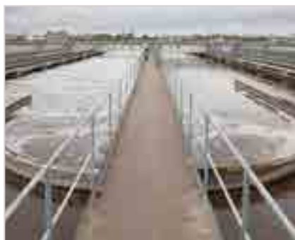
Рис. 13. Люберецкие очистные сооружения. Блок глубокой биологической очистки
