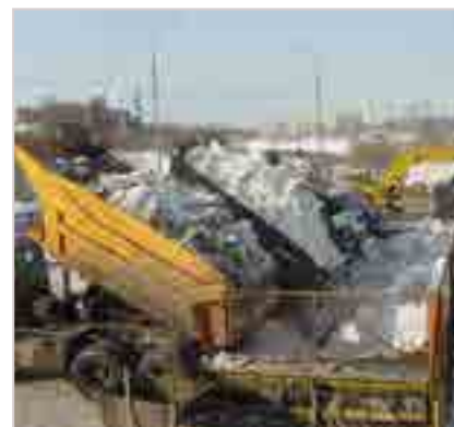
Рис. 19. Выгрузка снега в молотковую дробилку ССП
