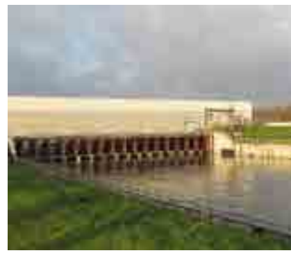
Рис. 12. Курьяновские очистные сооружения. Блок УФ-обеззараживания
