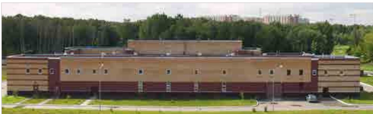
Рис. 8. Восточная станция водоподготовки. Комплекс обработки производственных стоков
