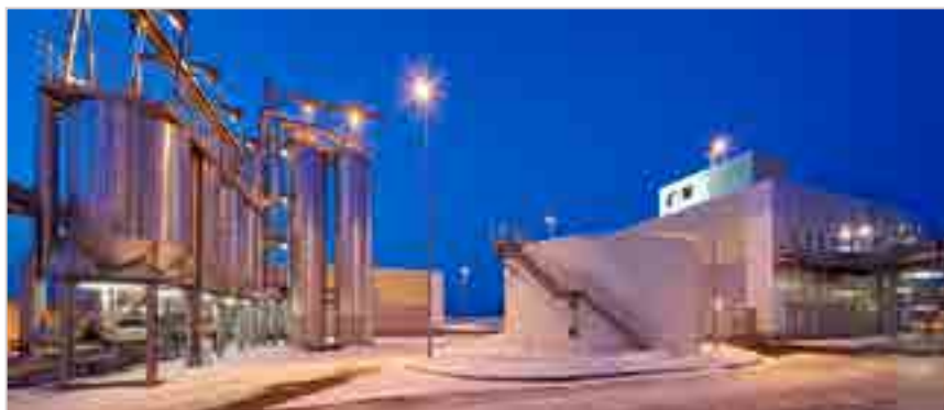
Рис. 15. Люберецкие очистные сооружения. Мини-ТЭС
