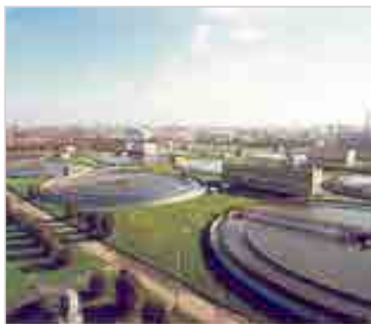
Рис. 10. Курьяновские очистные сооружения. Отстойники
