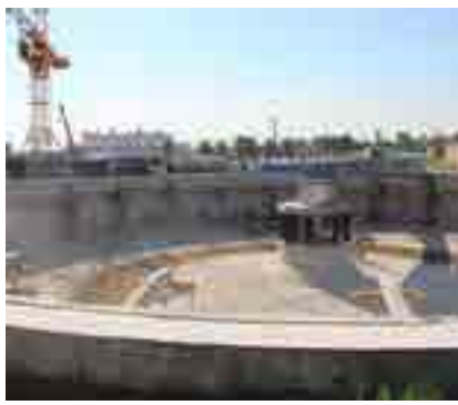
Рис. 11. Отстойник в стадии реконструкции
