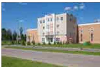
Рис. 1. Рублевская станция водоподготовки. Станция озонирования. Блок № 4
