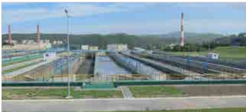
Рис. 18. Станции очистки сточных вод в г. Владивостоке
