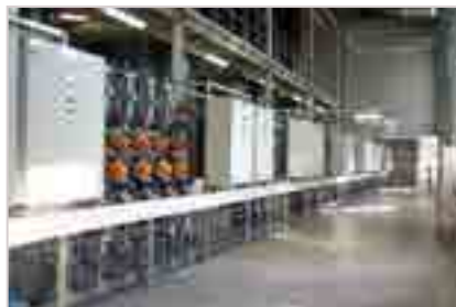
Рис. 7. Узел дозирования гипохлорита натрия
