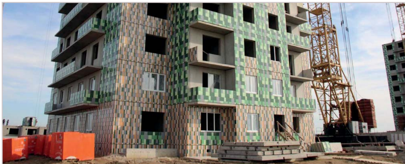
ООО «Лидер», строительство жилого комплекса в пос. Янино, Ленинградская область
