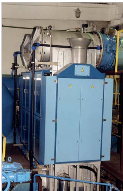
Установка УФ-обеззараживания
