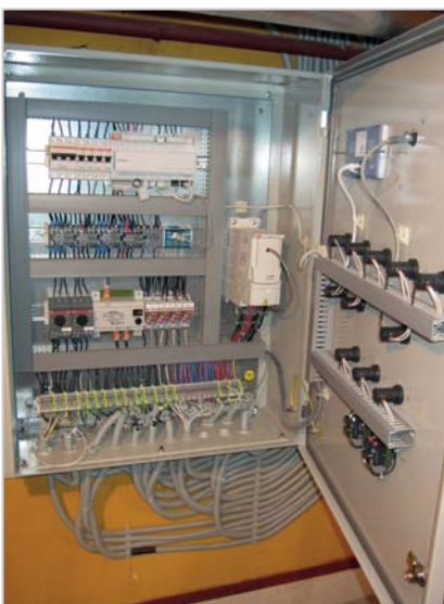
Щит управления ИТП KV Electro. TS.2.RMH760B
