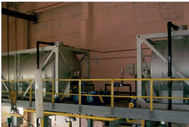
Блок сорбционной обработки воды
