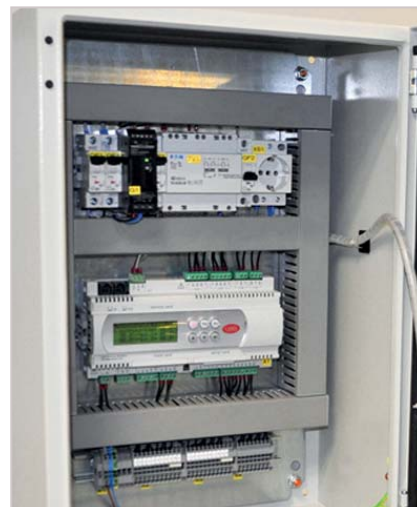
Устройство управления Chiller Manager обеспечивает согласованную работу чиллеров и интегрируется в систему диспетчеризации
