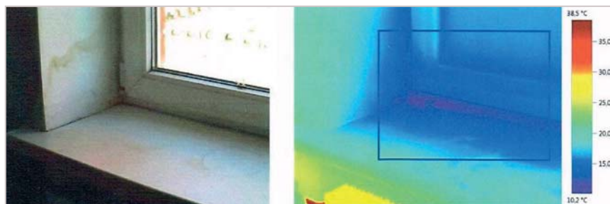
Рис. 2. Теплотехнические дефекты в узлах примыкания оконного блока к стеновому проему
