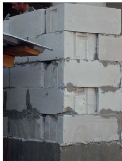
Рис. 6. Укладка поврежденных изделий в стену (узел сопряжения кладки газобетонных блоков с фундаментом)
