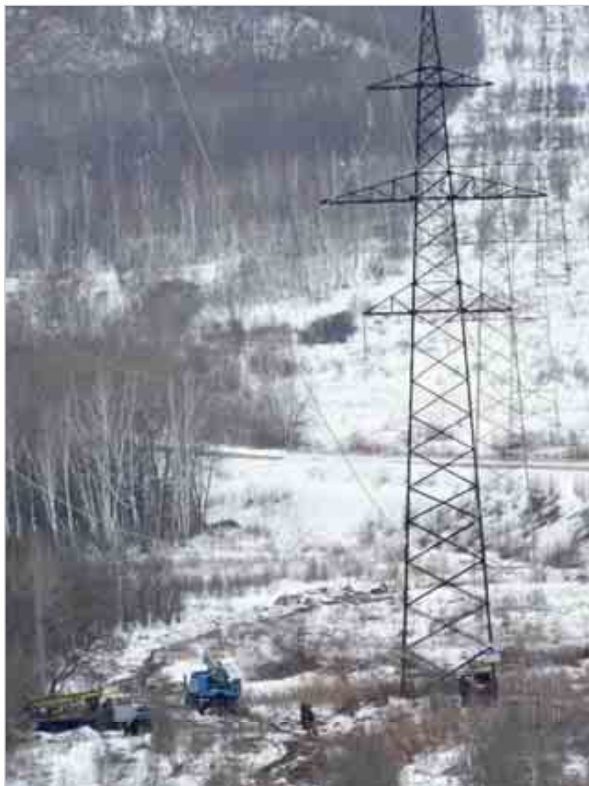
Рис. 7. Проведение инженерно-геологических изысканий (реновации) на трассе ВЛ 220 кВ «Бурейская ГЭС — Завитая цепь I, II» с проходкой шурфа для обследования фундаментов опоры
