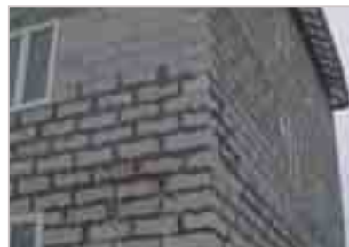
Рис. 5. Теплопроводные включения в виде швов кладки
