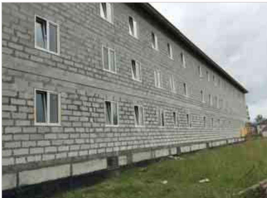
Рис. 1. Наружные стены до проведения работ по утеплению
