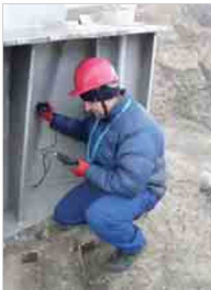
Рис. 2. Определение толщины стенки трубы приемного портала Чиркейской ГЭС ультразвуковым толщиномером А1209
