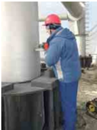
Рис. 14. Вырезка отверстия для обследования внутренней поверхности металлической трубы переходной опоры Чиркейской ГЭС
