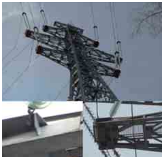
Рис. 13. Примеры точек наведения визирного луча тахеометра для определения координат точек подвеса проводов и тросов переходной опоры 220 кВ Воткинской ГЭС
