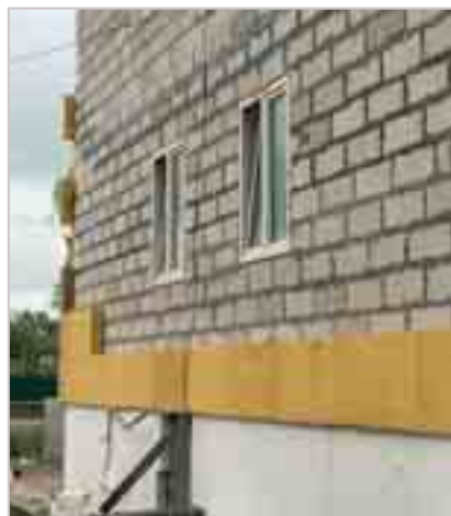
Рис. 8. Утепление торцевой стены
