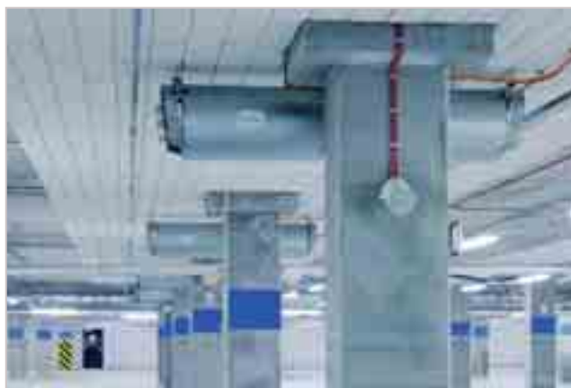
Рис. 2. Струйные вентиляторы, установленные на потолочном перекрытии подземной автостоянки
