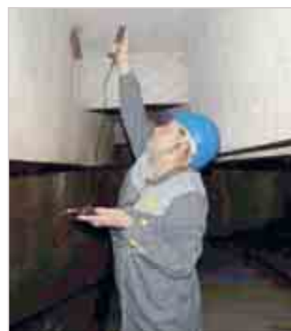
Рис. 5. Определение остаточной прочности бетона плиты перекрытия здания ГЭС Воткинской ГЭС методом ударного импульса прибором ОНИКС-2.6
