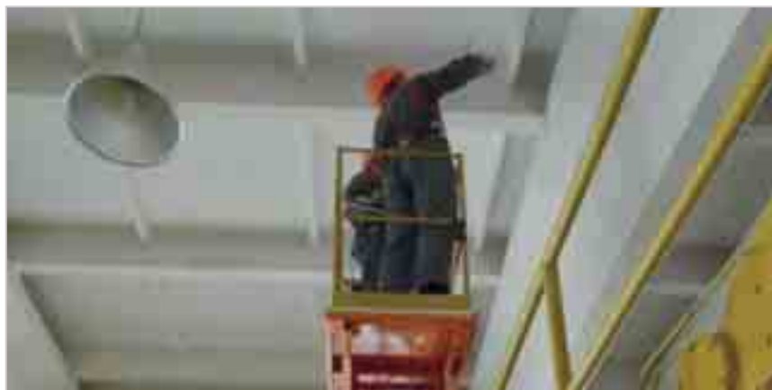
Рис. 9. Обследование кровельных балок и плит покрытия машинного зала Воткинской ГЭС с тележки мостового крана
