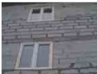
Рис. 3. Теплопроводные включения в уровне межэтажных перекрытий
