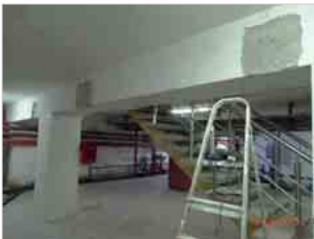
Рис. 10. Подготовка мест испытания на железобетонной балке перекрытия здания ГЭС, включающая в себя удаление штукатурного слоя и шлифовку поверхности бетона
