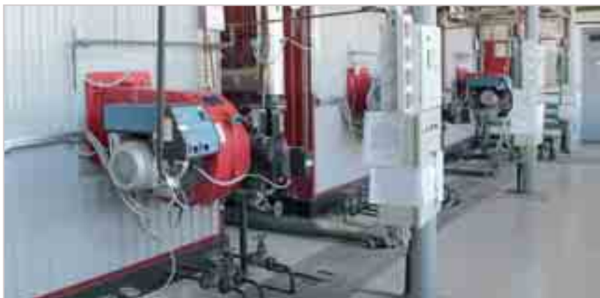
Автоматизированная котельная
