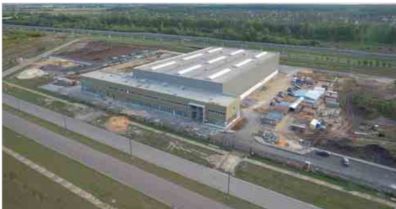
Строительство завода Viessmann в Липецкой области, октябрь 2016
