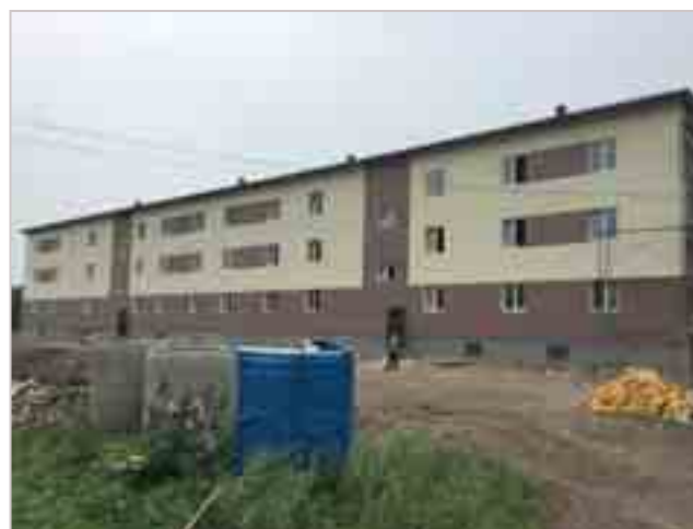
Рис. 11. Завершение фасадных работ
