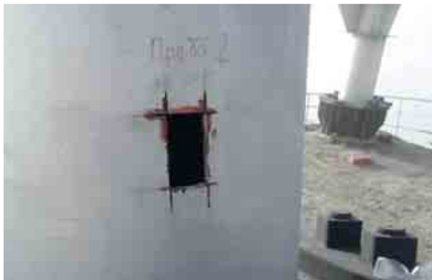
Рис. 15. Отверстие для обследования внутренней поверхности металлической трубы переходной опоры Чиркейской ГЭС
