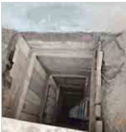
Рис. 8. Общий вид шурфа, пройденного в рамках обследования фундаментов здания ОПУ 220 кВ Воткинской ГЭС
