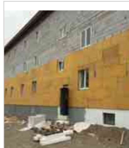
Рис. 9. Утепление главного фасада здания
