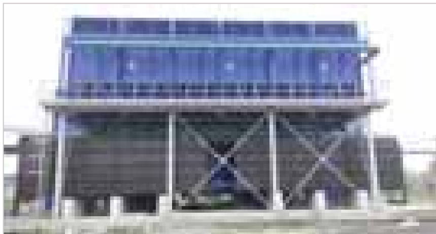
Рис. 1. Модульная эжекционная безвентиляторная градирня
