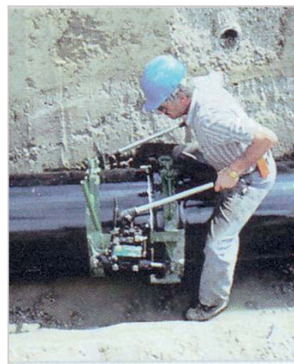
Рис. 4. Монтаж ВЧШГ-труб с полиуретановым покрытием
