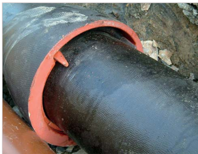
Рис. 3. Сейсмостойкое соединение ВЧШГ-труб
