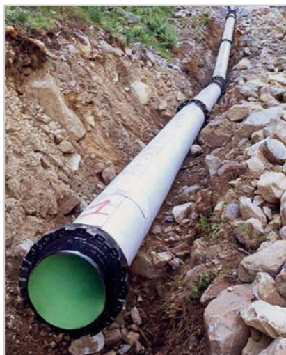
Рис. 4. Монтаж ВЧШГ-труб с полиуретановым покрытием
