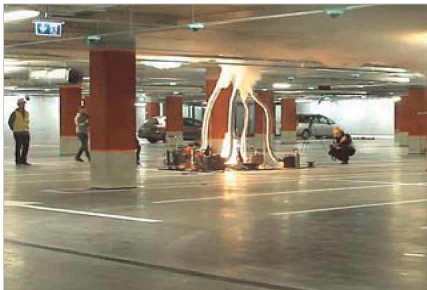
Рис. 5. Испытание противодымной вентиляции с использованием горячего дыма
