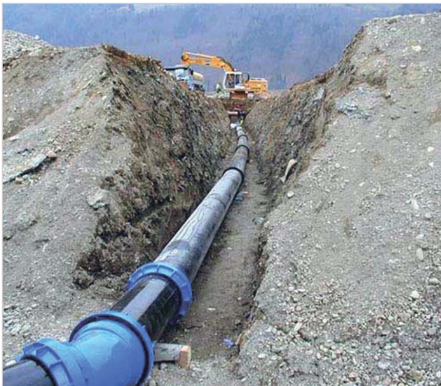
Рис. 2. Укладка труб в траншее
