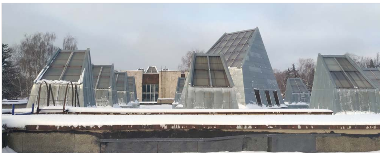
Фото 2. Фонари. Вид с крыши
