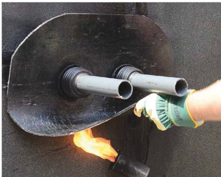
HL800.2 сдвоенная газоводонепроницаемая мембрана
