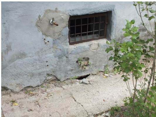
Рис. 5. Строительно-эксплуатационные дефекты ограждающих конструкций: а — деструкция элементов покрытия; б — обеспечение требуемых уклонов кровли; в — разрушение в зоне примыкания отмостки к цоколю; г — неутепленные конструкции подвала
