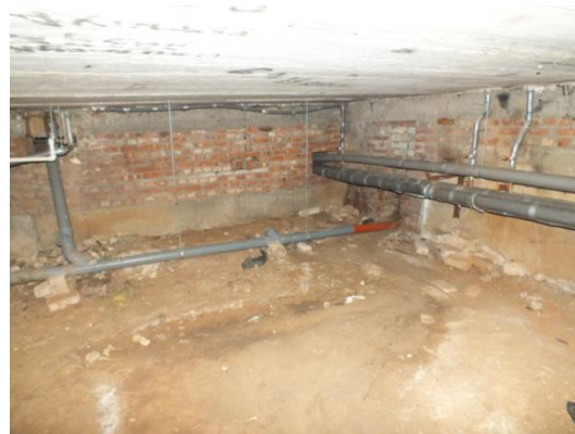
Рис. 5. Строительно-эксплуатационные дефекты ограждающих конструкций: а — деструкция элементов покрытия; б — обеспечение требуемых уклонов кровли; в — разрушение в зоне примыкания отмостки к цоколю; г — неутепленные конструкции подвала
