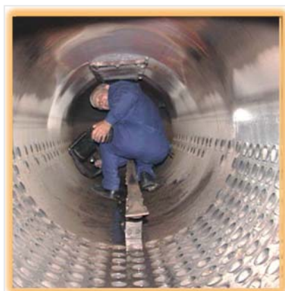
Без химводоподготовки Через 8 месяцев после ЭМВ Рис. 7. Результаты применения ЭМВ на паровом котле
