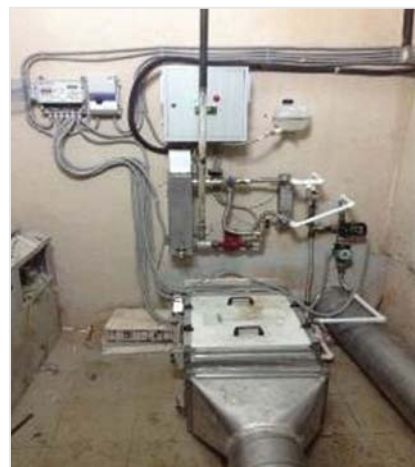
Система воздушного отопления АТП-ТермаРОН/В
