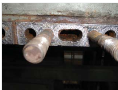
Рис. 16. Состояние системы в местах подключения радиаторов после обработки
