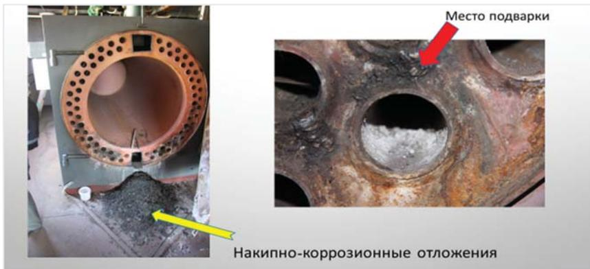
Рис. 20. Состояние импортного котла при недостаточной водоподготовке
