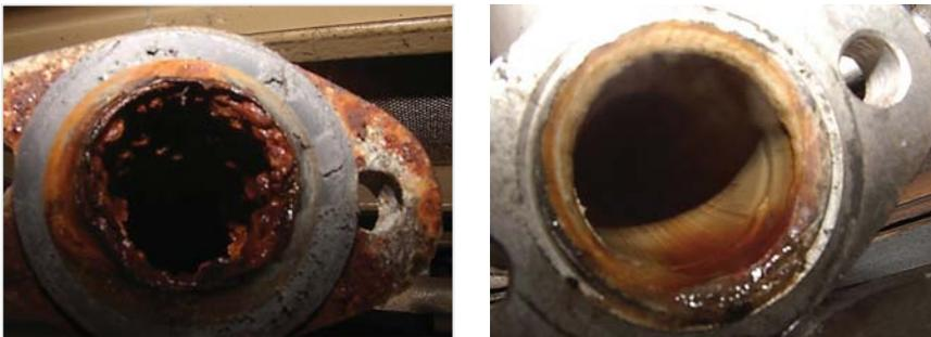
Рис. 14. Состояние системы водоснабжения пассажирского вагона до и после обработки
