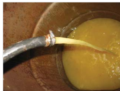
Рис. 9. Промывка системы водой после запуска энергента
