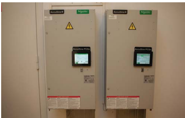
Устройство динамической компенсации реактивной мощности снижает суммарный коэффициент гармонических искажений с 14 до 2,5%
