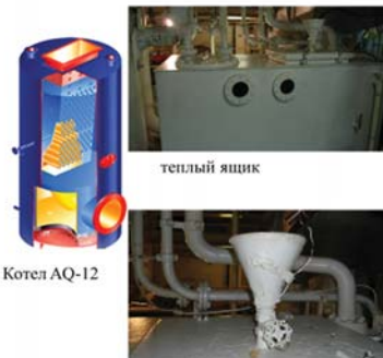
Место ввода суспензии ремонтного состава
