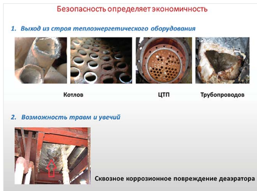
Рис. 2. Состояние теплоэнергетического оборудования при несоблюдении нормативных параметров ВХР
