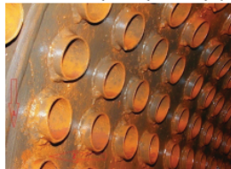
Состояние экономайзера и нижнего барабана котла после обработки (депо Свердловск).
