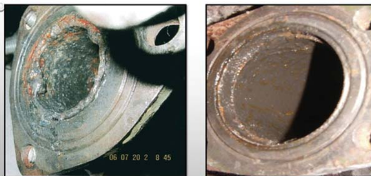
Рис. 12. Внешний вид трубопровода отопления вагона после химической очистки (слева) и после применения энергетического метода (справа)
