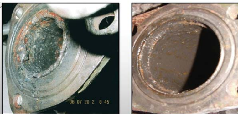
Внешний вид трубопровода отопления вагона после химической очистки (слева) и после применения энергетического метода (справа)
