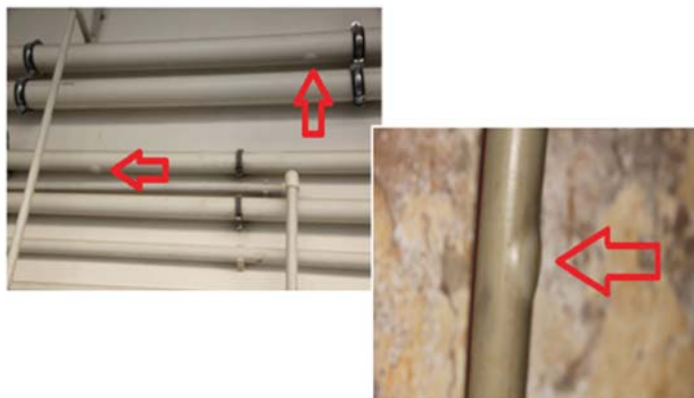
Рис. 10. Вид разрушения пластиковых конструкций в системах теплоснабжения ремонтных предприятий
