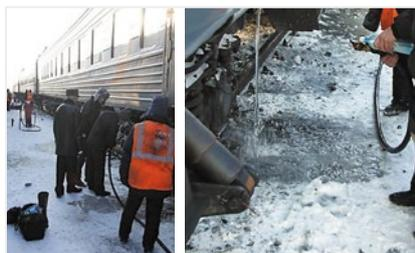
Рис. 4. Поточная обработка систем водотеплоснабжения пассажирских вагонов в эксплуатационном депо
