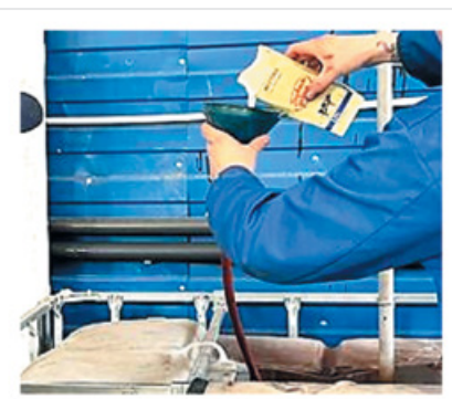
Рис. 12. Введение энергента при ЭМВ в сеть парового котла
