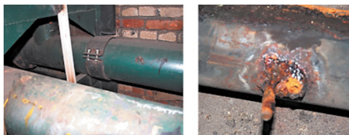
Рис. 7. Внешний вид системы ГВС пассажирского депо при невыполнении требований нормативов по скорости коррозии
