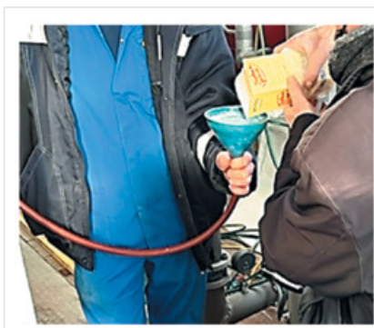
Рис. 12. Введение энергента при ЭМВ в сеть парового котла
