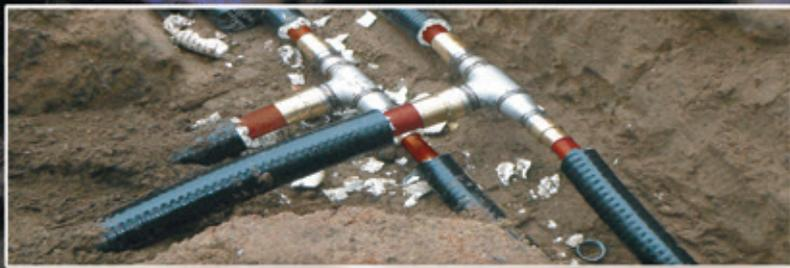
температурный график  $+95^{\circ}+70^{\circ}$  С при давлении до 10 кг/см<sup>2</sup> ● диаметр труб до 160/225мм
