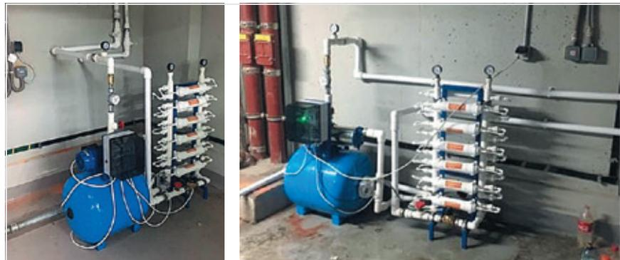
Рис. 5. Внешний вид установки ультрафильтрации для «байпасной» очистки горячей воды циркуляционного контура системы горячего водоснабжения гостиницы «Хаятт» (Москва). Производительность — 1000 литров в час
