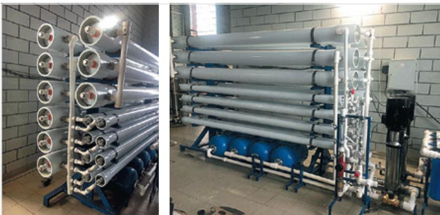
Рис. 3. Установка обратного осмоса производительностью 30 куб. м в час для водоснабжения автономных объектов с системой сокращения расхода концентрата до 1–0,5 куб. м в час
