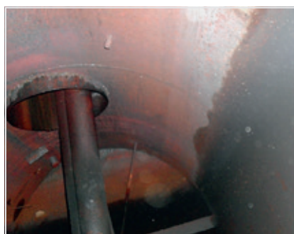
Рис. 9. Вид на паровое пространство бака питательной воды через 11 месяцев после обработки (2014 год). Отчетливо видна защитная пленка
