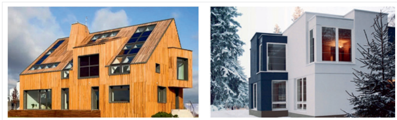
Рис. 2. Первый в России «Активный дом», построенный в Наро-Фоминском районе Подмосквья датской компанией Velux и компанией «Загородный проект» (23) и первый в России жилой дом площадью 246 м 2 , получивший сертификат немецкого института Passive House, построенный компанией ЗАО «Мосстрой-31» в районе Южное Бутово в Москве (24)
