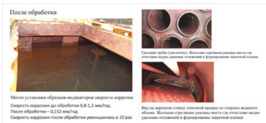
Рис. 17. Изменение состояния водного тракта котельной судна и некоторых параметров ВХР через 12 месяцев после обработки
