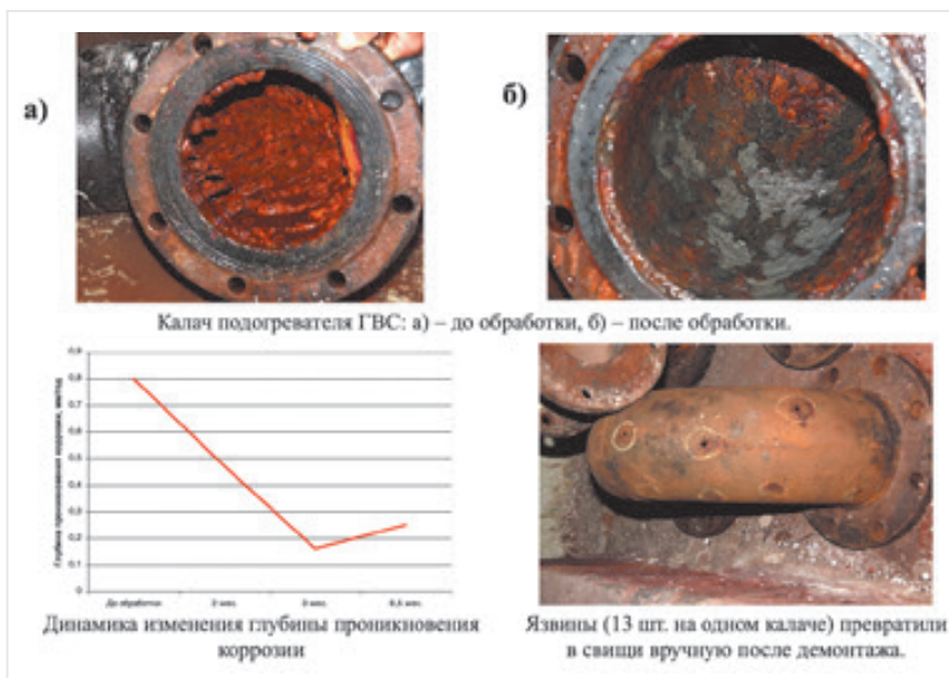
Рис. 5. Применение ЭМВ при обработке изношенных тепловых сетей
