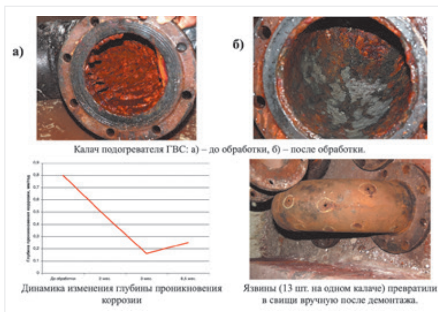
Рис. 5. Применение ЭМВ при обработке изношенных тепловых сетей
