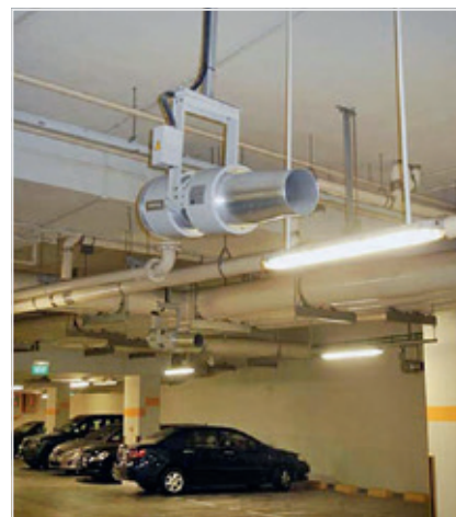
Рис. 6. Устройство крепления струйного вентилятора на стойке с возможностью регулирования углового положения в вертикальной и горизонтальной плоскости
