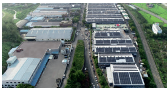
Завод в г. Чхондо
