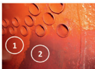
Рис. 16. Введение суспензии порошка-энергента в сеть ГВС
