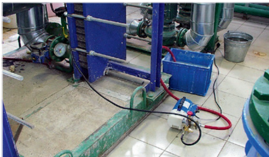
Рис. 16. Введение суспензии порошка-энергента в сеть ГВС
