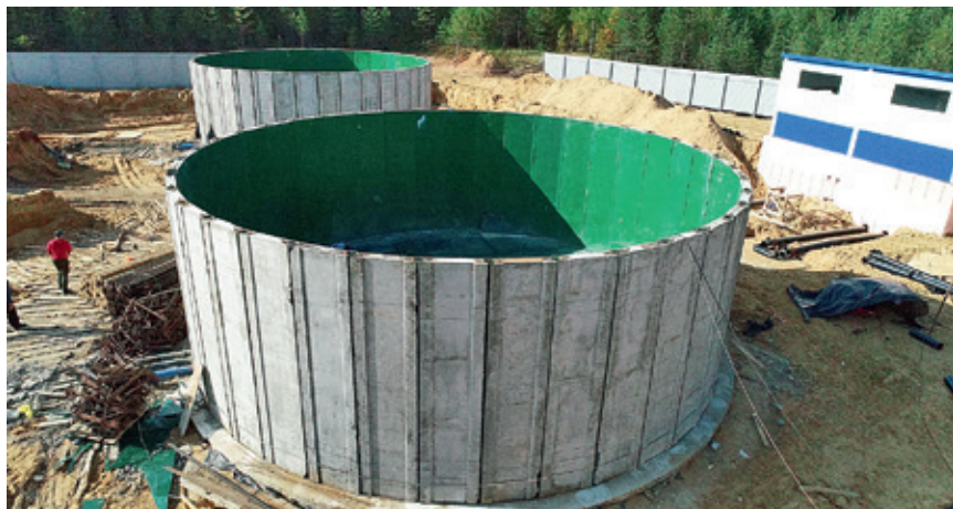
Рис. 2. Накопительная железобетонная емкость
