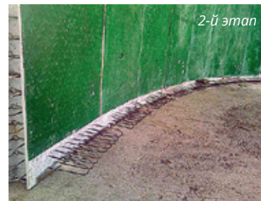
Рис. 5. Монтаж днища железобетонного резервуара
