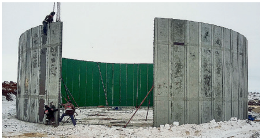
Рис. 3. Принцип нанесения полиэтиленовых покрытий
