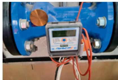
Рис. 5. Общедомовой прибор учета тепла в здании
