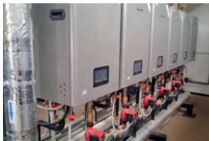
Рис. 4. Индивидуальная крышная блочная газовая котельная
