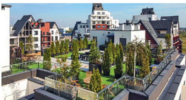
Рис. 6. Эксплуатируемая кровля в каждом доме
