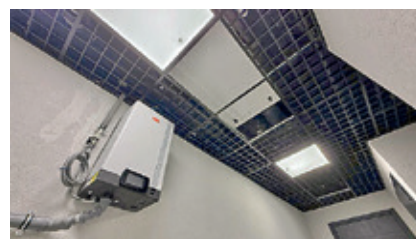
Рис. 4. Рекуператоры и увлажнители воздуха в каждой квартире
