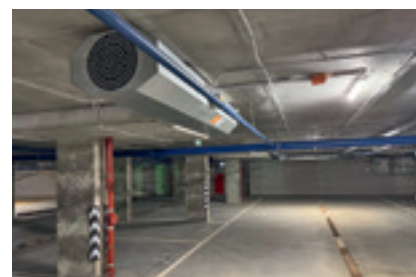
Рис. 5. Струйный вентилятор Р+1 в подземной автостоянке г. Казани
